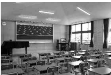
学校施設長寿命化計画による適切な施設改修を終えた南小学校北校舎
