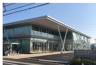
「図書館・保健センター複合施設」
