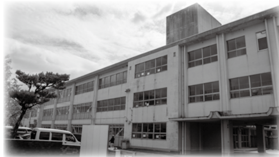
改築が始まる南小学校の北校舎
