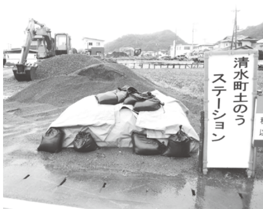
浸水被害を軽減する土のうの活用を
