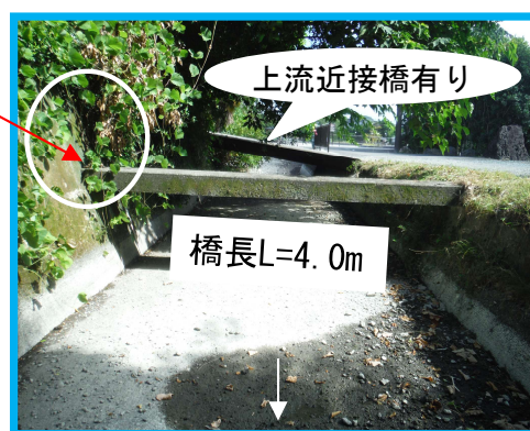
下流より全景（上流近接橋有り）
