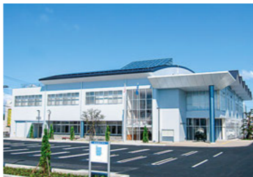
平成21年(2009年) 地域交流センターオープン Opening of Community Exchange Center
