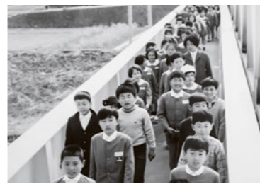
昭和45年(1970年) 徳倉橋歩道橋完成 Completion of the footbridge for Tokura Bridge
