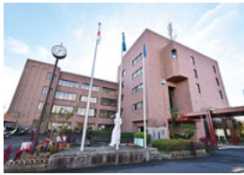
清水町役場 Shimizu Town Office
