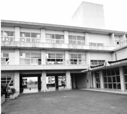
改築計画が進む南小学校北校舎
