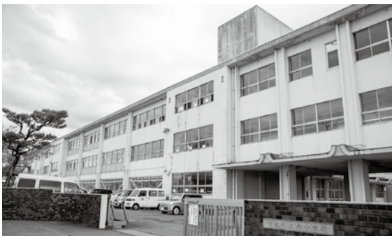
改築予定の南小学校北校舎
