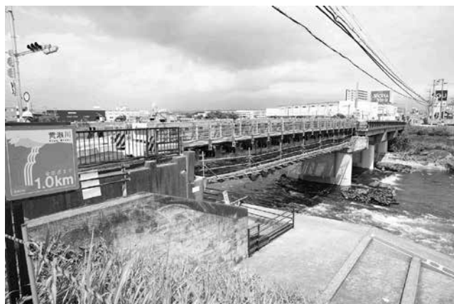
本格復旧が待たれる黄瀬川大橋（応急仮設橋）
