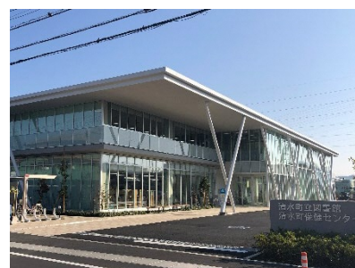
「図書館・保健センター複合施設」
